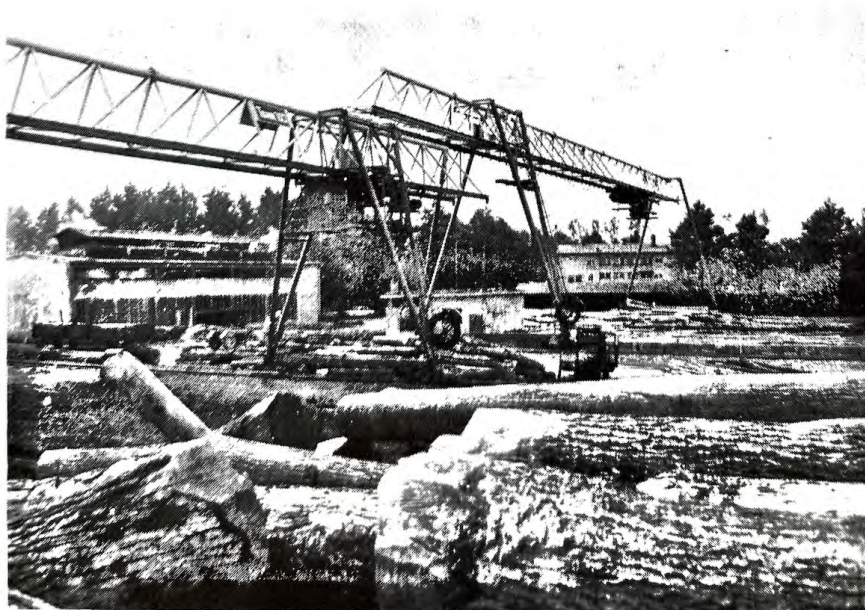
Suvremeno rješenje skladišta trupaca s portalnim dizalicama u pilani DI »Česma« Bjeļovar. (Foto: A. Sorić)
