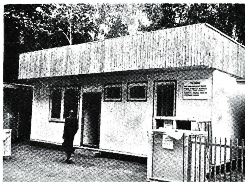
Slika 6. Drveni namjenski objekt
