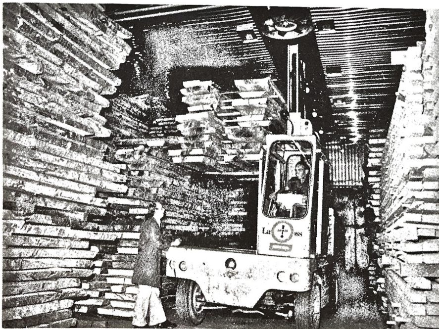
BOČNI VILIČAR PUNI KOMORE PILJENOM GRABOM OBOSTRANO U VENTILATORSKOM KORIDORU
