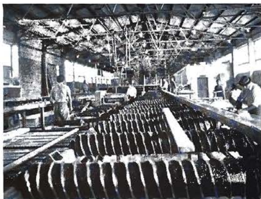
Detalj unutrašnjeg transporta u Josipdolu — realizacija tehnologije Instituta — isporučilac opreme DK Đurđenovac
