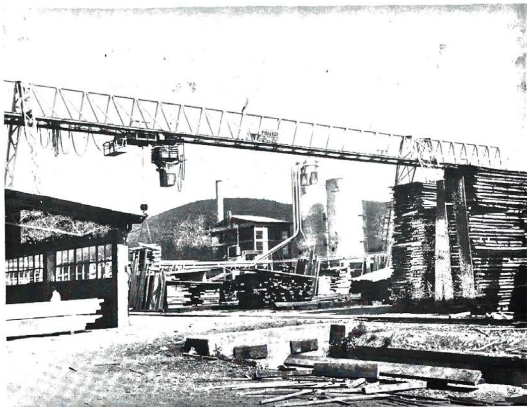
Suvremeno rješenje transporta po projektu Instituta za drvo u DIP-u Ogulin
