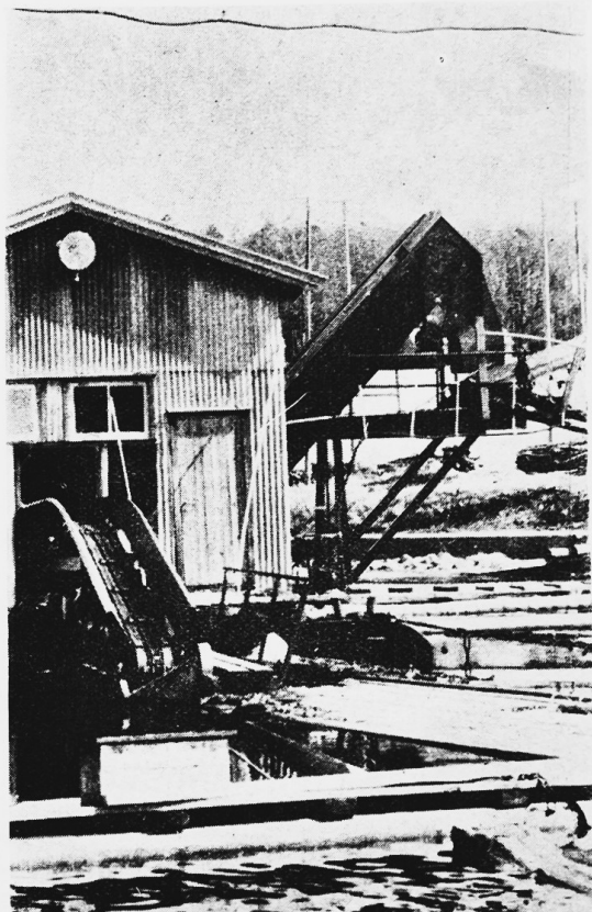
Sl. 2 — Postrojenje za koranje trupaca smješteno na jednom vodenom stovarištu. Naprijed je transporter za izbacivanje okoranih trupaca, a po strani je transporter za otpremu kore
