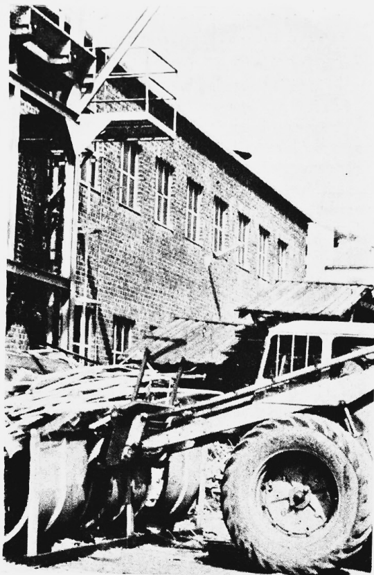
Sl. 15 — Otprema pilanskih otpadaka pomoću specijalnog traktora viličara. Otpaci se transportiraju viličarom direktno na vagon kojim se dalje otpremaju do tvornice papira ili ploča.
