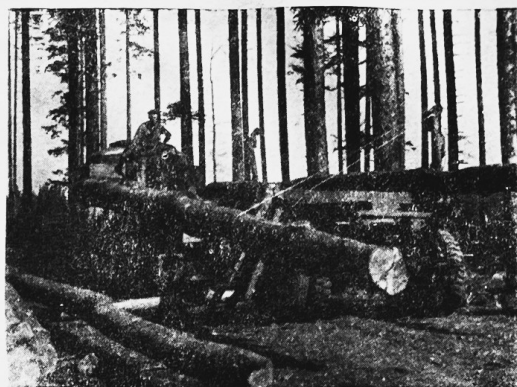
Sl. 5. Utovar oblovine pomoću bubnja TB montiranog na kamionu (Lesni zavod Jesenik)
