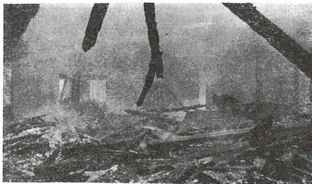
Slika 2. Uništena upravna zgrada Kombinata Belišće
