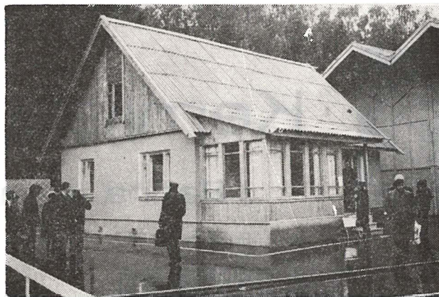
Slika 11. Obiteljska kuća tip 181-115-99/1, 2 od drvnih panela
