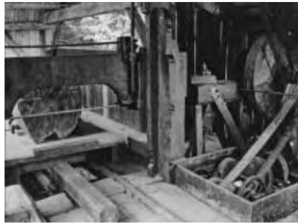
Figure 3 Water-driven sawmill with a horizontal blade built at Dolní Sloupnice in 1854; moved to the Open-Air Museum of Folk Architecture Vysočina (Štěpán et al , 2000) Slika 3. Vodom pogonjena pilana s horizontalnim listom pile izgrađena u Dolní Sloupnice 1854. godine; premještena u Muzej narodne arhitekture na otvorenome u Vysočini (Štěpán et al , 2000)
