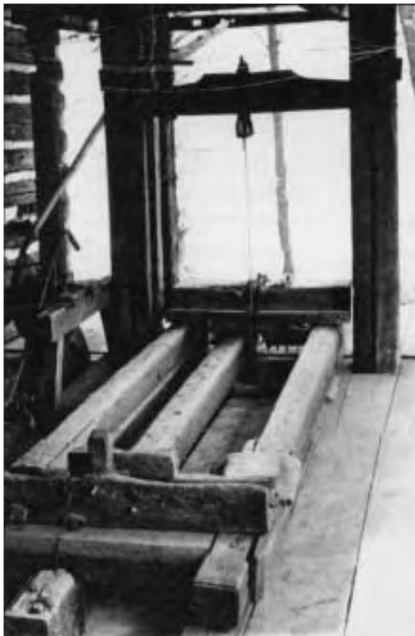
Figure 2 Water-driven single blade sawmill restored at a watermill in 1796 (Štěpán et al , 2000) Slika 2. Vodom pogonjeni pilanski stroj s jednim listom pile iz 1796. godine (Štěpán et al , 2000)
